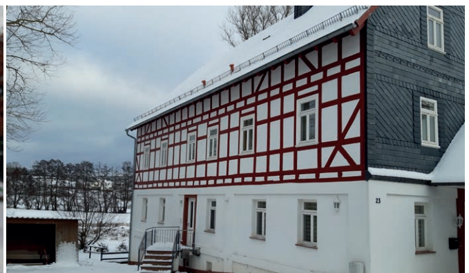
Ehemalige Mühle in Mittel-Simtshausen
